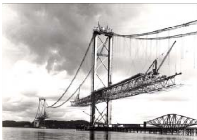
Краны для строительства моста через Форт, Великобритания
