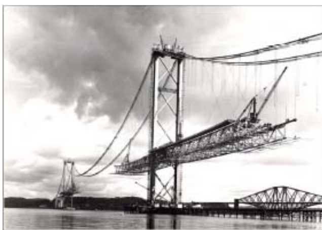
Краны для строительства моста через Форт, Великобритания
